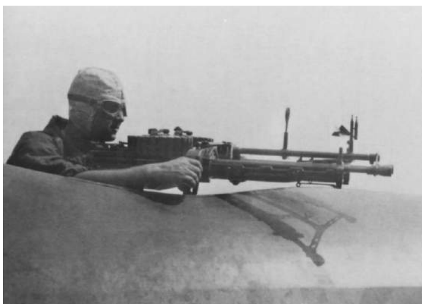
Montaje doble de ametralladoras Lewis en el puesto del observador de un Ab.101 nacional. Adviértase la barra central que soporta los elementos de puntería: una parrilla y un punto de veleta (“wind vane”). Lo vemos aquí desplegado, en disposición de fuego, manejado por el alférez Ricardo del Arco Martín.
