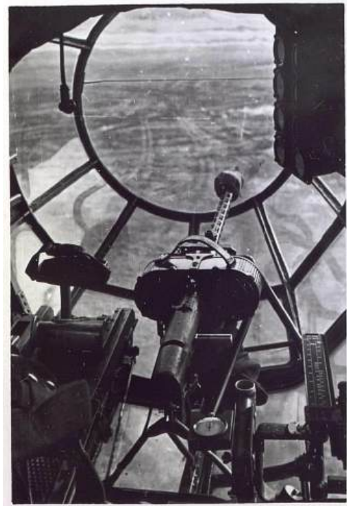
Sistema de engarce de la ametralladora MG.15 al afuste semi-rígido de proa.
