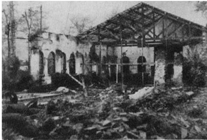
Fábrica de Trubia. Pabellón destruido por los bombardeos aéreos.
