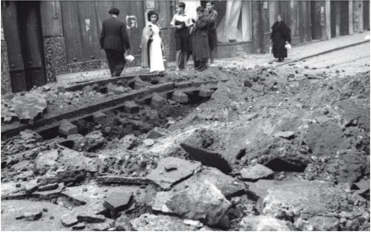
Desperfectos causados por las bombas en los carriles de la red de tranvías.
