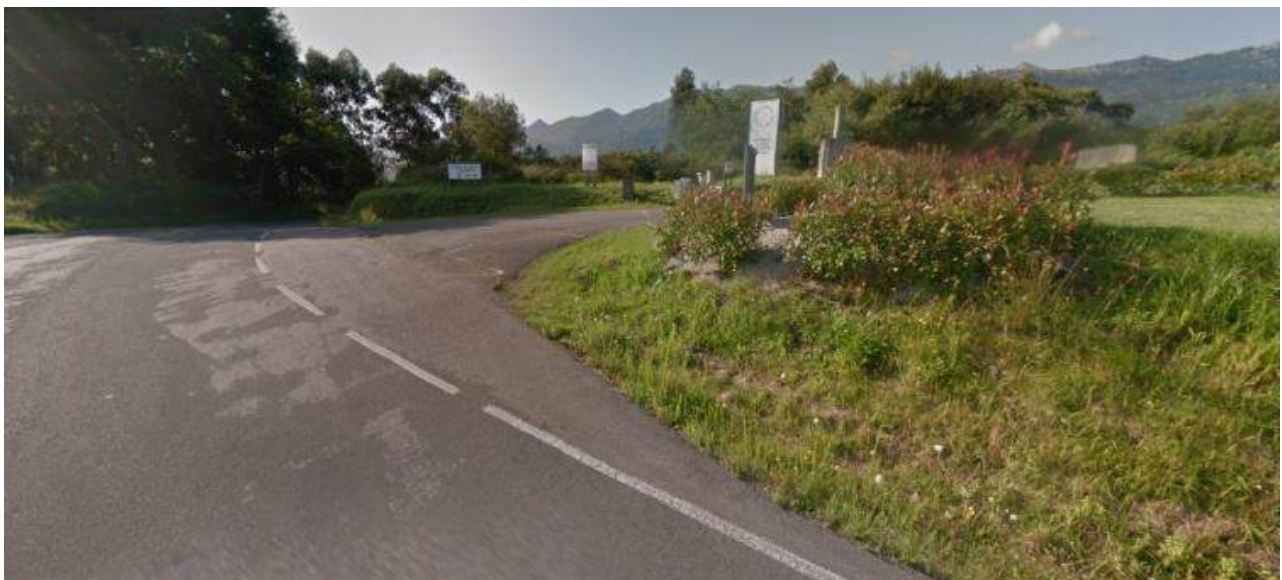
Arriba. Las baterías A.A. pesadas del F/88 llegan al alto de la Boriza, donde se halla el acceso al aeródromo de Cué, a remolque de sus semiorugas Sd Kfz 7. Abajo. Aspecto actual de ese mismo lugar.
