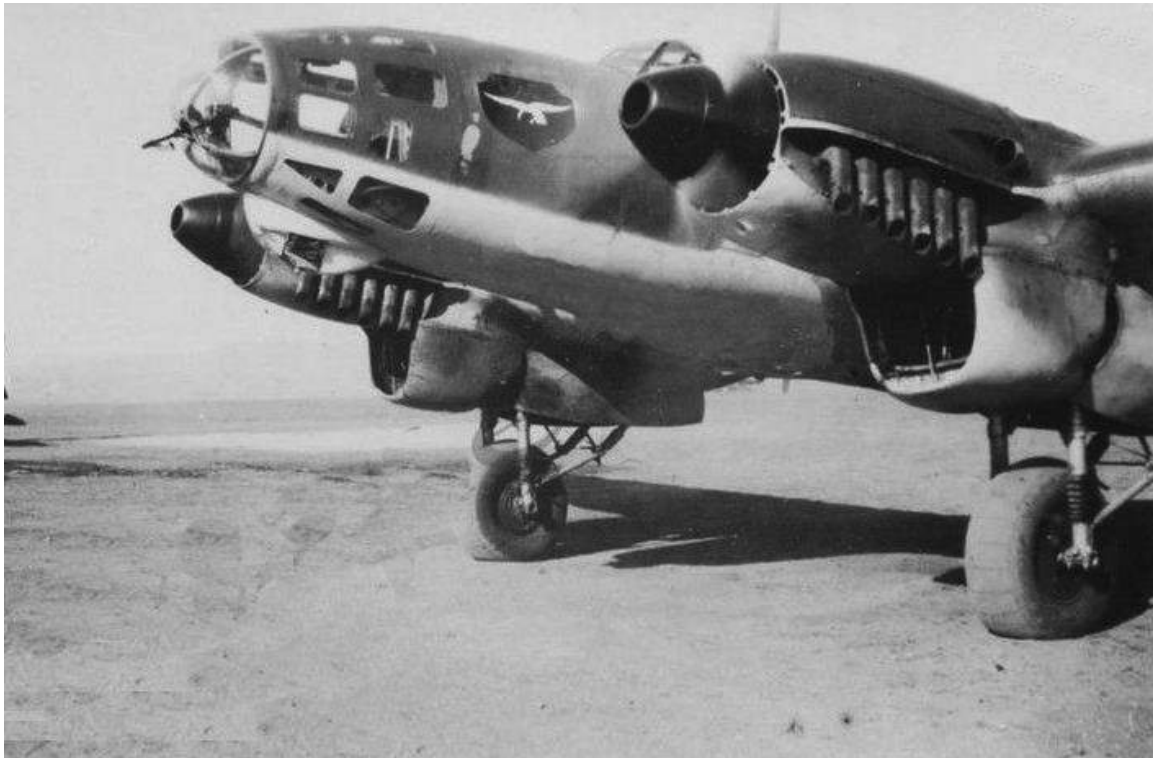
Motores DB 600 CG de un He.111 B-2
