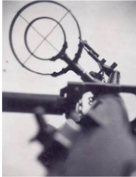
Sistema de engarce de la ametralladora MG.15 al afuste semi-rígido de proa.
