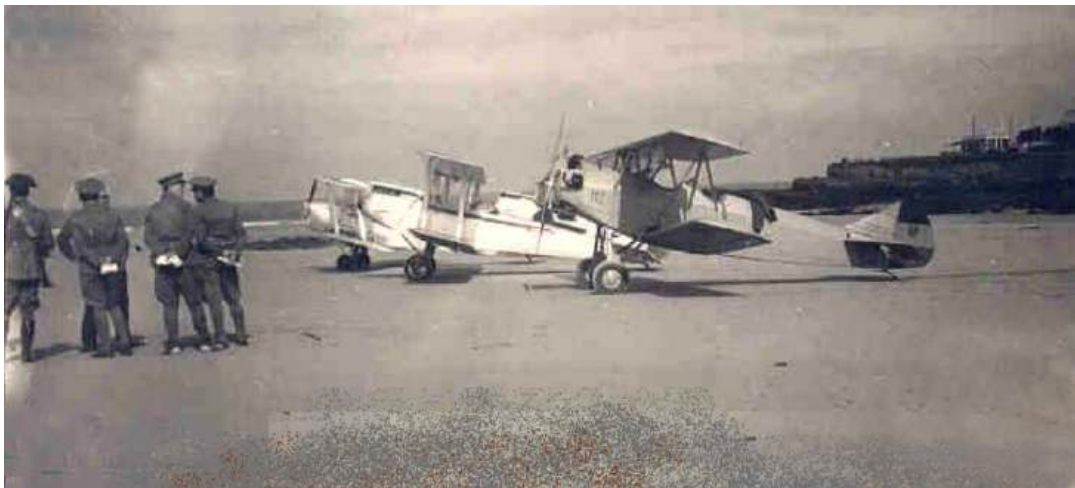
Avionetas aparcadas en la playa de Gijón. En primer término la Fleet 10, de la Aeronáutica Naval. Tras ella, una D.H.60 Metal Moth y una D.H.82 Tiger Moth de la Escuela de Vuelo y Combate de Alcalá de Henares.
