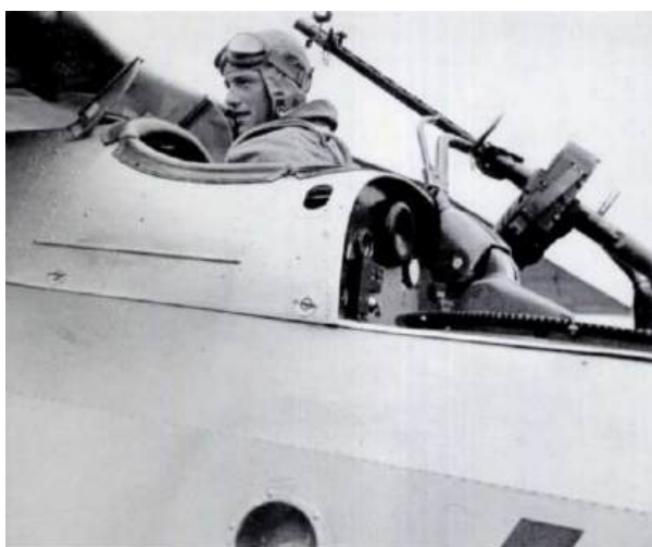
Puesto del observador/bombardero de un Heinkel He.45 y detalle de su ametralladora MG. 15; destaca la bolsa para la recogida de las vainas vacías de los cartuchos disparados
