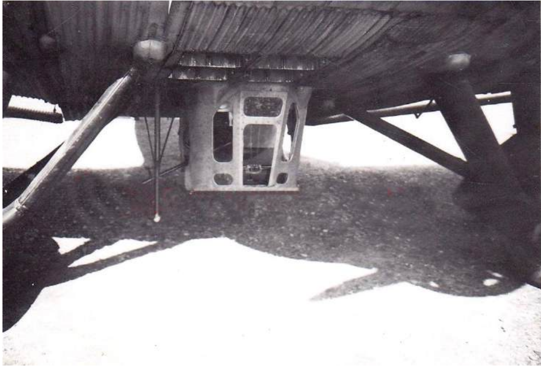
El “cubo” del ametrallador-bombardero de un Ju.52 en su posición de repliegue máximo para poder maniobrar en tierra.
