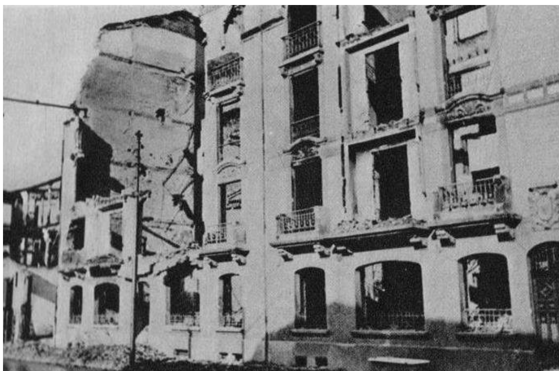
Plaza de América. Destrozos que los continuados bombardeos van dejando en el centro de Oviedo.
