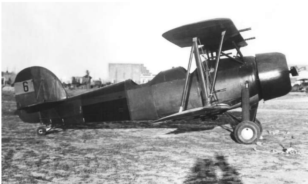
Koolhoven FK.51. Se aprecian las dos Vickers de 7,7 en el plano superior y los lanzabombas. La foto está probablemente tomada en Valencia.
