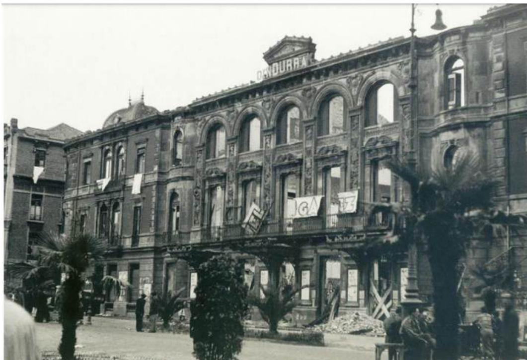
El teatro Dindurra una vez extinguido el fuego. La destrucción de su interior fue total.
