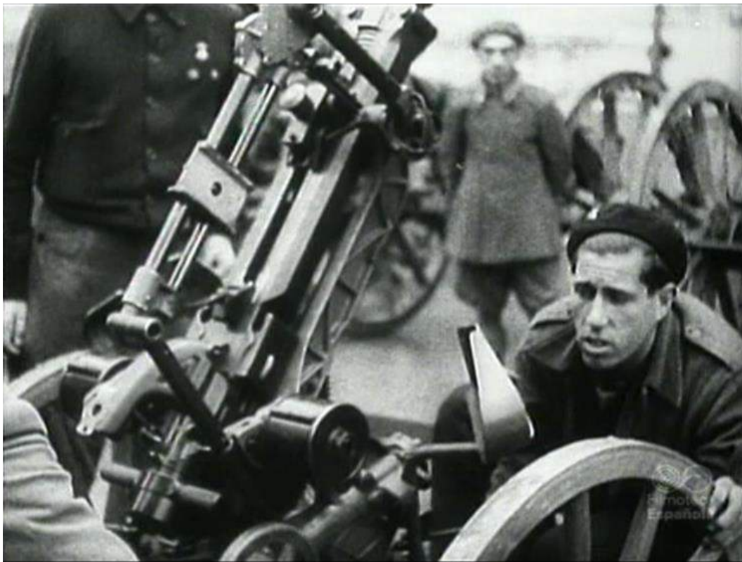
Ametralladora antiaérea republicana Oerlikon 1S de 20 mm sobre montaje JLaS
