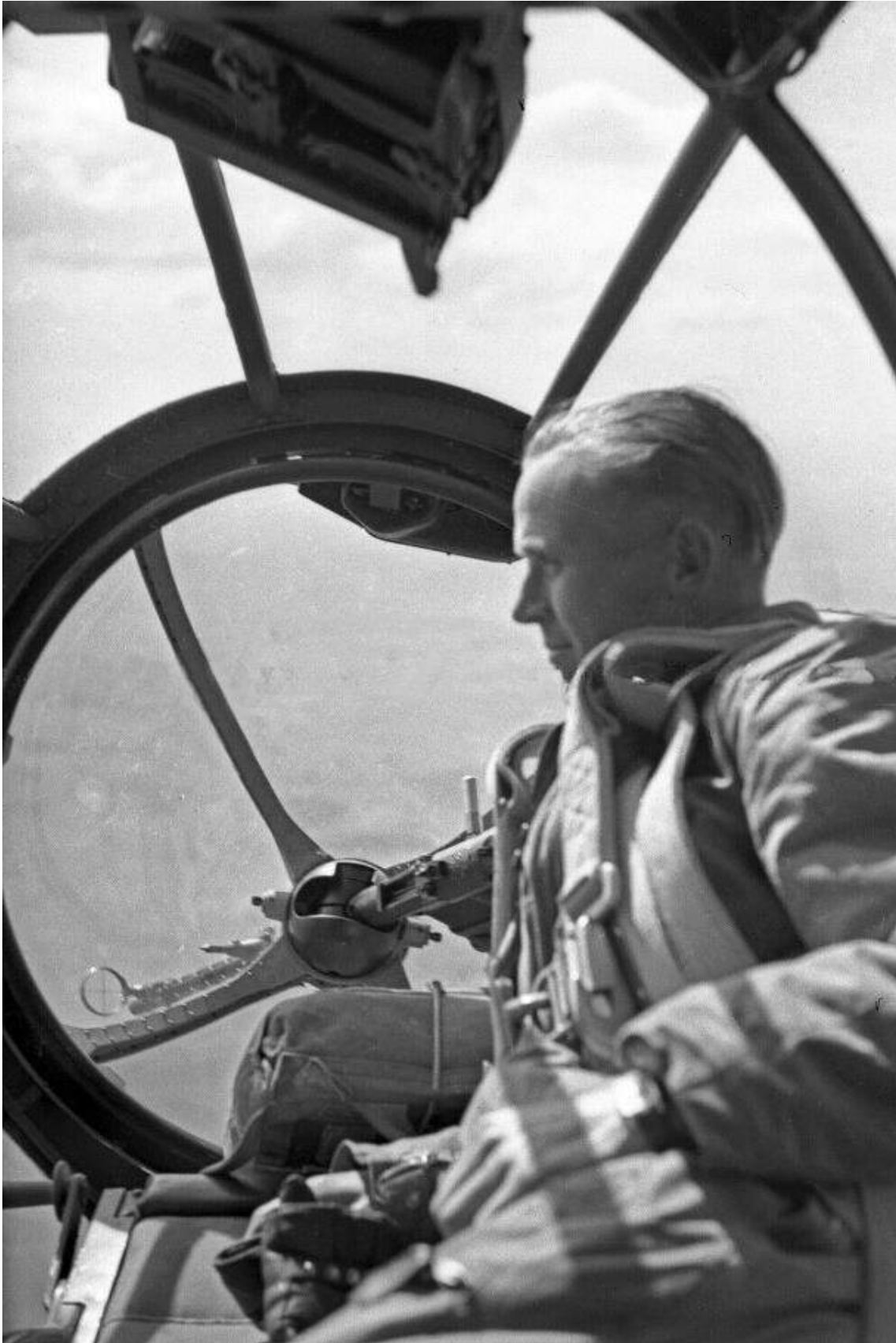
Atilero de proa de un He.111 B posa ante su ametralladora MG.15 emplazada en un montaje cruciforme de Ikaria Werke.
