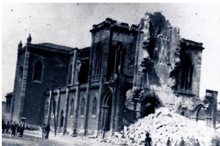
Iglesia parroquial de San José. Estado que presentaba tras la primera voladura, que sólo derribó la torre y el pórtico de la entrada.
