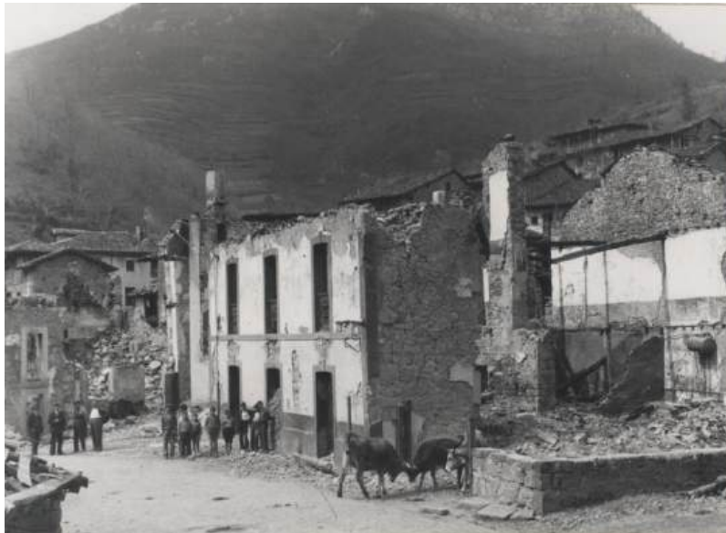
Efectos de los bombardeos en Campo de Caso. Ruinas del Ayuntamiento.
