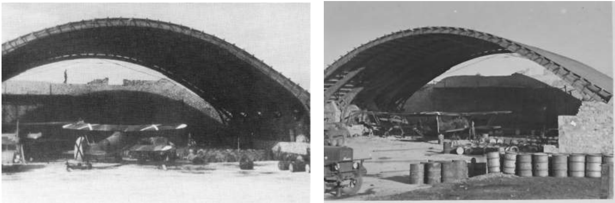
Los Heinkel He.51 de la Escuadrilla 3.J/88 aprovechaban para su reparación o recorrido el inconfundible y singular hangar del aeródromo de Cué que, como vemos, estaba sin concluir a falta de un par de arcadas de la bóveda y la terminación de la pared de cierre del fondo
