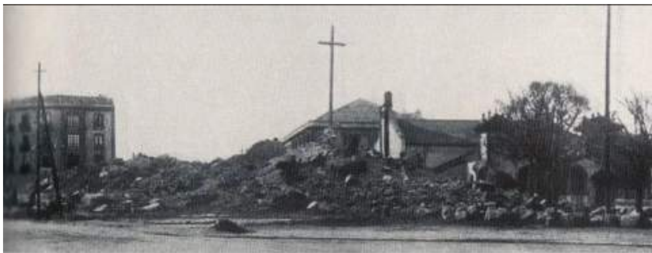
La misma Iglesia de San José tras las voladuras que la arrasaron por completo.
