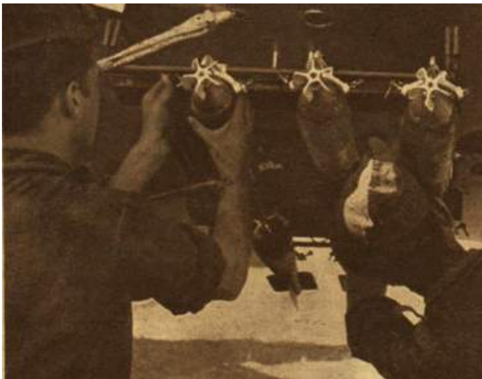
Armeros de Aviación completando en un Breguet XIX la carga ofensiva usada habitualmente sobre Asturias: seis bombas A.5, de 12 kilos, bajo cada uno de los planos inferiores en sus correspondientes lanzabombas 3-A-5 ó 6-A-5
