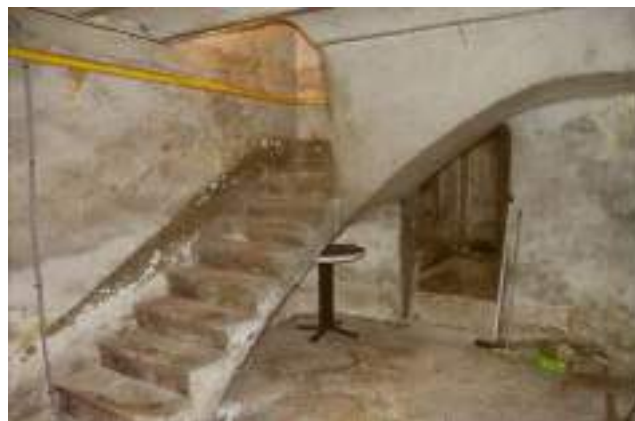
Estado actual de uno de los sótanos acondicionados como refugios en Gijón
