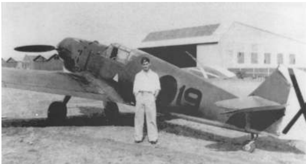
El 6-19 en La Virgen del Camino. Fue el primer Bf.109B-1 llegado a España ya con la hélice metálica tipo Hamilton de origen.
