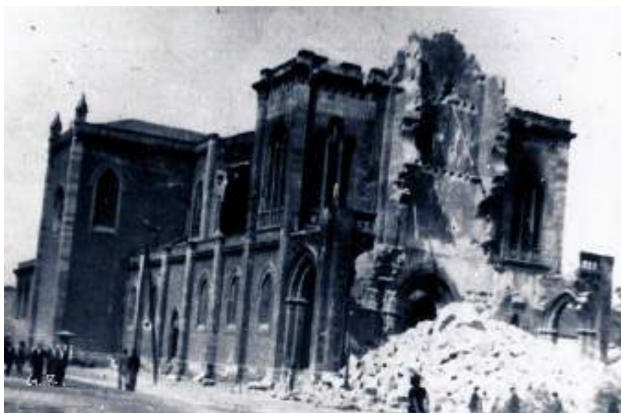
Iglesia parroquial de San José. Estado que presentaba tras la primera voladura, que sólo derribó la torre y entrada.
