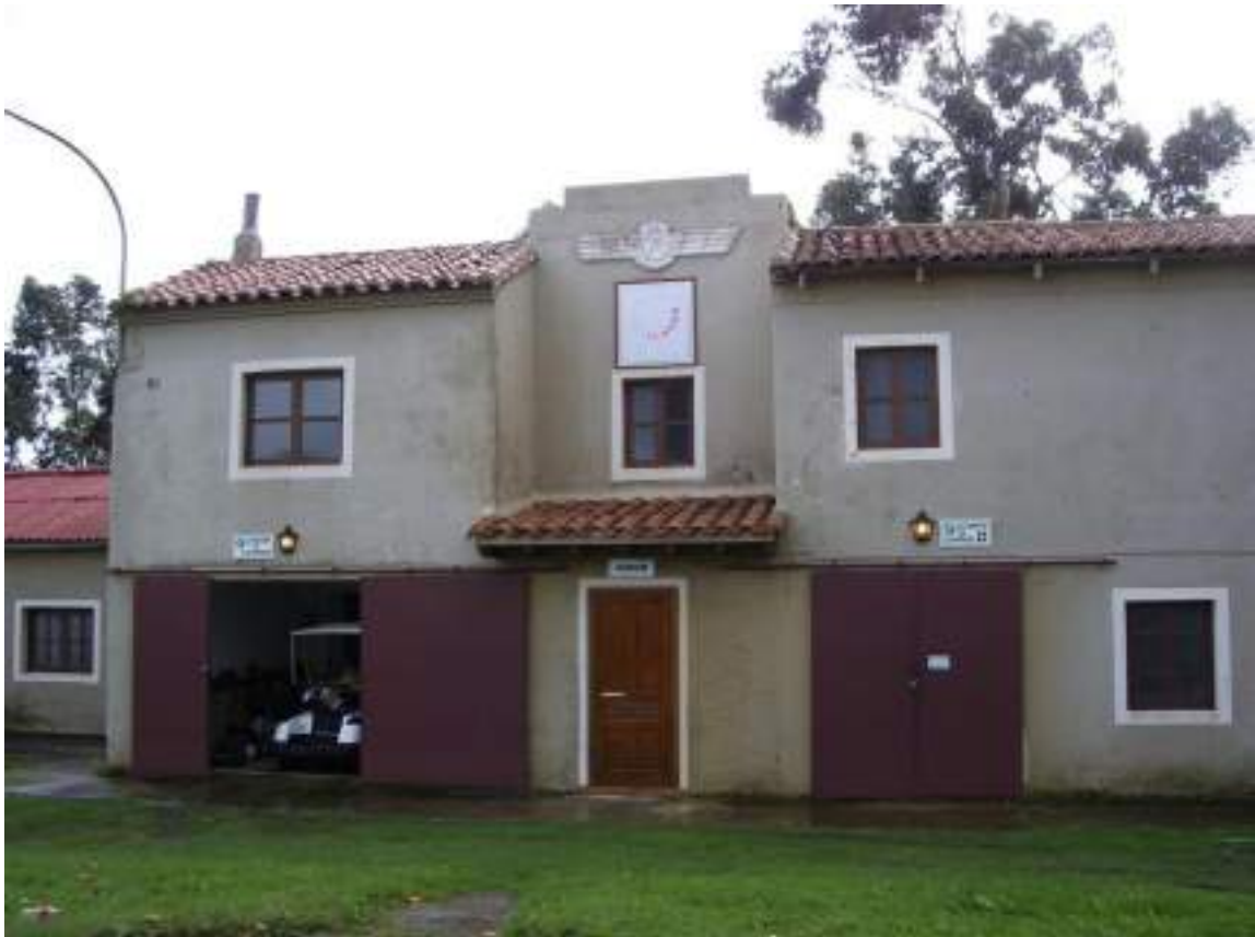
Estado actual del edificio de la foto anterior, conservado como sede del Club de Golf establecido sobre el que fuera campo de vuelo. Obsérvese que mantiene el emblema del Ejército del Aire
