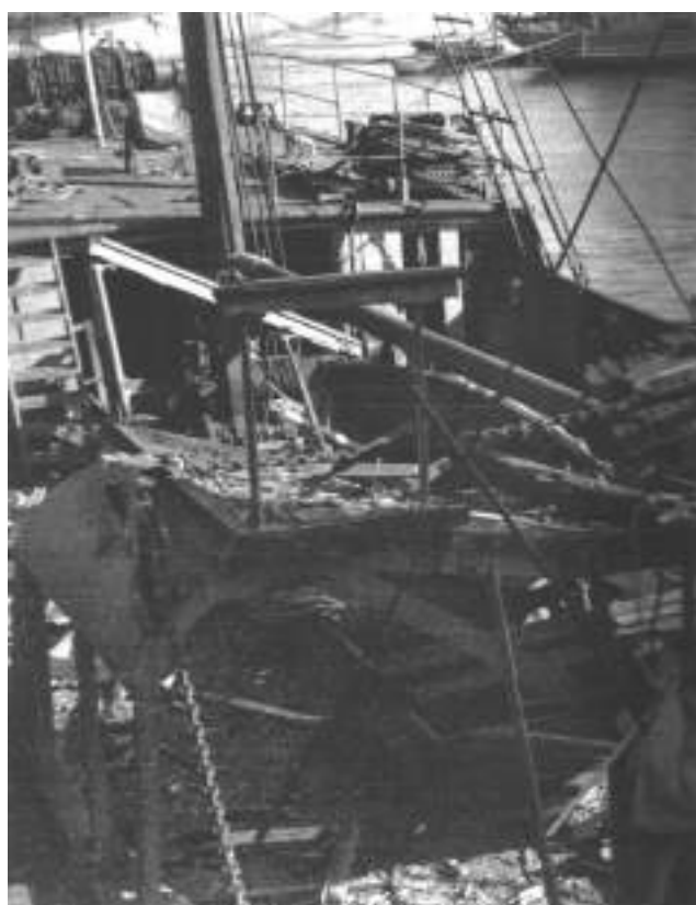
Mercante impactado durante el bombardeo del puerto de El Musel del 21 de octubre
