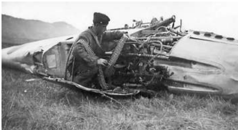
Pese a los destrozos, la foto permite hacerse una idea de cuál era la disposición de las dos ametralladoras MG.17 que montaba el 6-12.
