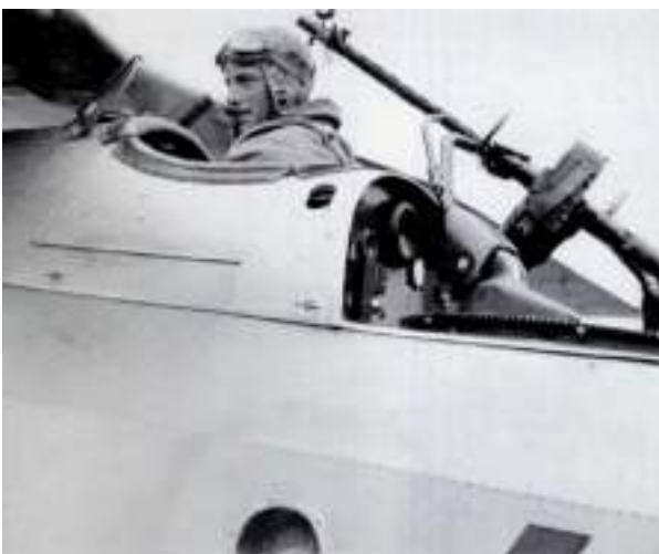
Puesto del observador/bombardero de un Heinkel He.45 y detalle de su ametralladora MG. 15; destaca la bolsa para la recogida de las vainas vacías de los cartuchos disparados
