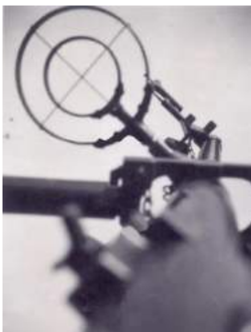
Sistema de engarce de la ametralladora MG.15 al afuste semi-rígido de proa.
