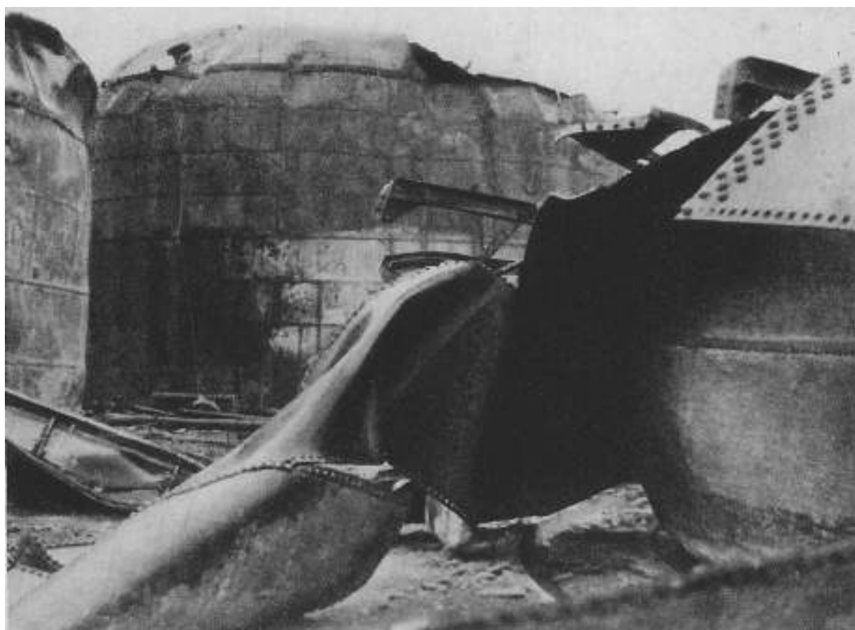
Aspecto que presentaban los depósitos dela CAMPSA de Gijón una vez extinguido su incendio (Foografía Hemeroteca Nacional)
