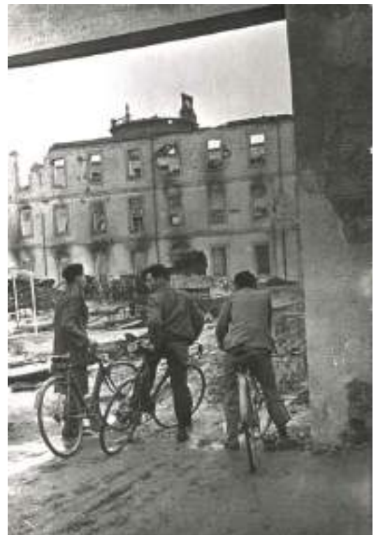
Abajo.- Las ruinas del Cuartel de Simancas, una vez aplastada su resistencia. (Foto inferior David Seymour)
