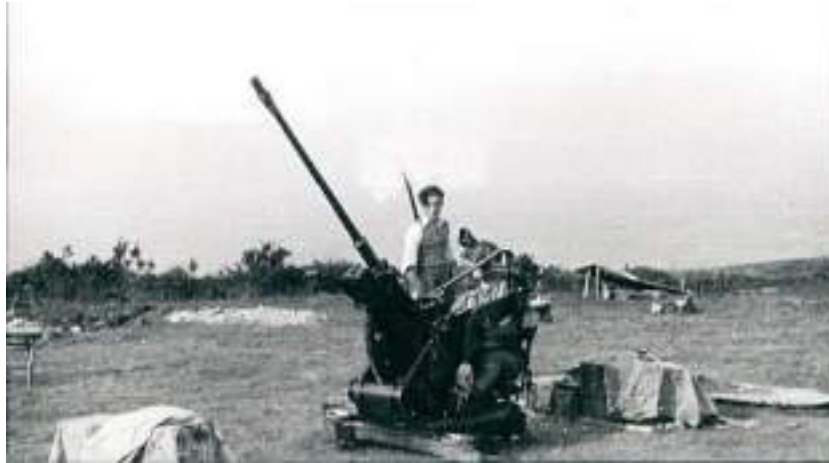
Ametralladora Flak 30 de 30 mm emplazada próxima al campo de vuelo de Cué para la defensa contra ataques aéreos a baja cota
