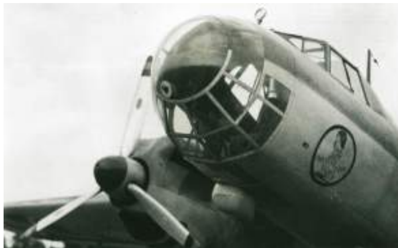
Tres Dornier Do.17 E-1 (De arriba abajo: 27-15 -“Buhó en la rama”; 27-9 “Papa’s Liebling” y 27-25 “Barón de Münchhausen sobre una bomba SC”) nos muestra claramente la parrilla del conjunto de puntería externa; en la de arriba, casi tapando por la ametralladora del parabrisas, a causa del encuadre.
