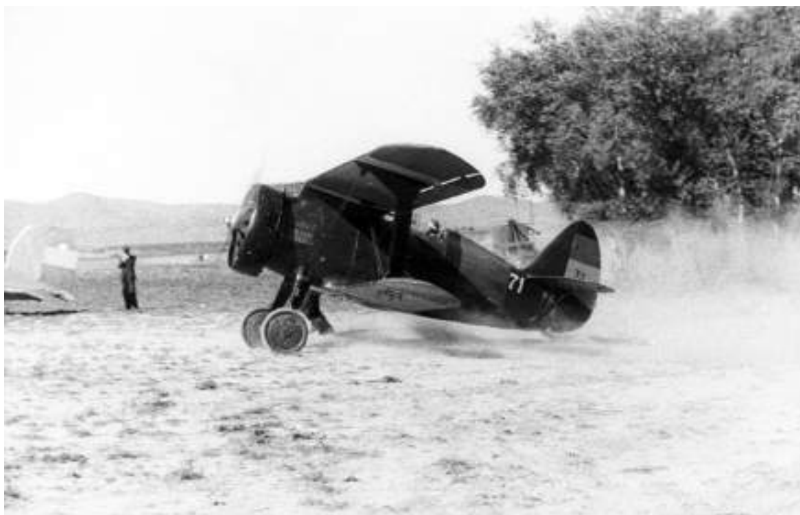
Fotografía conocida, ya que ha sido publicada en varias ocasiones sin identificar nunca el lugar en que fue tomada, que muy bien pudiera ser el Norte republicano. En cualquier caso, lo que aquí nos interesa de ella es que nos muestra los dos lanzabombas, para otra tantas bombas rusas de 25 kilos, montados bajo su plano inferior izquierdo.
