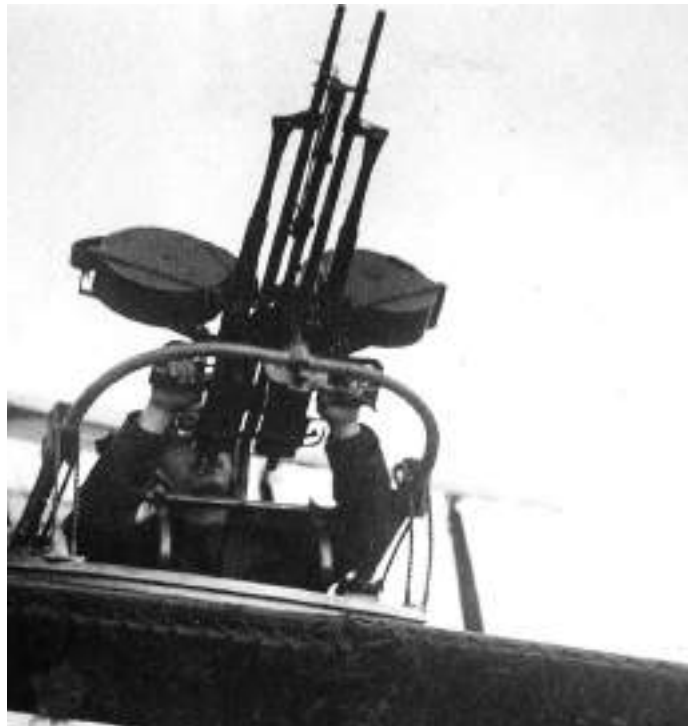
Montaje doble de ametralladoras Darne. Su aspecto sobre la torreta Scarff y provisto de los dos tambores de munición resultaba, cuando menos, espectacular.
