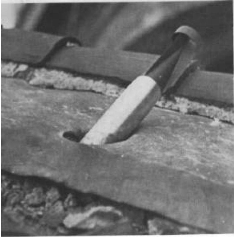
Bomba incendiaria B 1E incrustada en un tejado sin llegar a atravesarlo.
