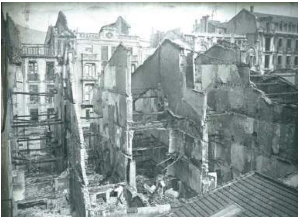
Estragos causados por el fuego en la calle San Francisco
