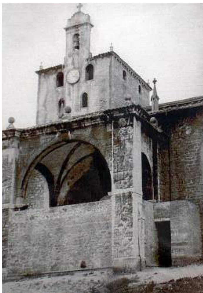
Iglesia de Santa María de la Asunción, de Llanes, reforzada con muros de hormigón para convertirla en refugio antiaéreo.
