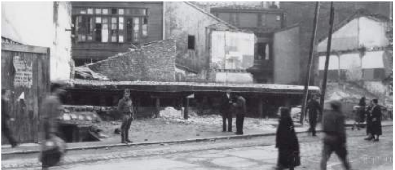
Refugio en construcción en la calle Menéndez Valdés, de Gijón
