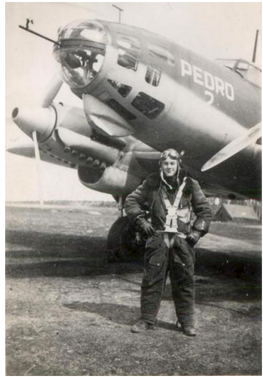
El 25-3 “Pedro 1” y el 25-1 “Pedro 2” mostrando los montajes semicirculares de la ametralladora de proa originales, con los que llegaron a España.
