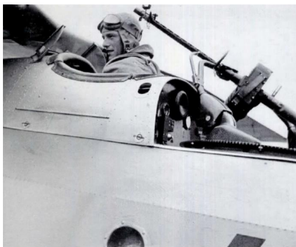
Puesto del observador/bombardero de un Heinkel He.45 y detalle de su ametralladora MG. 15.
