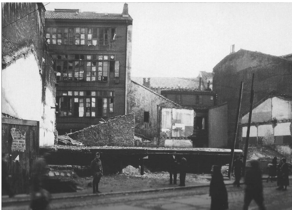
Refugio en construcción en la calle Menéndez Valdés, de Gijón
