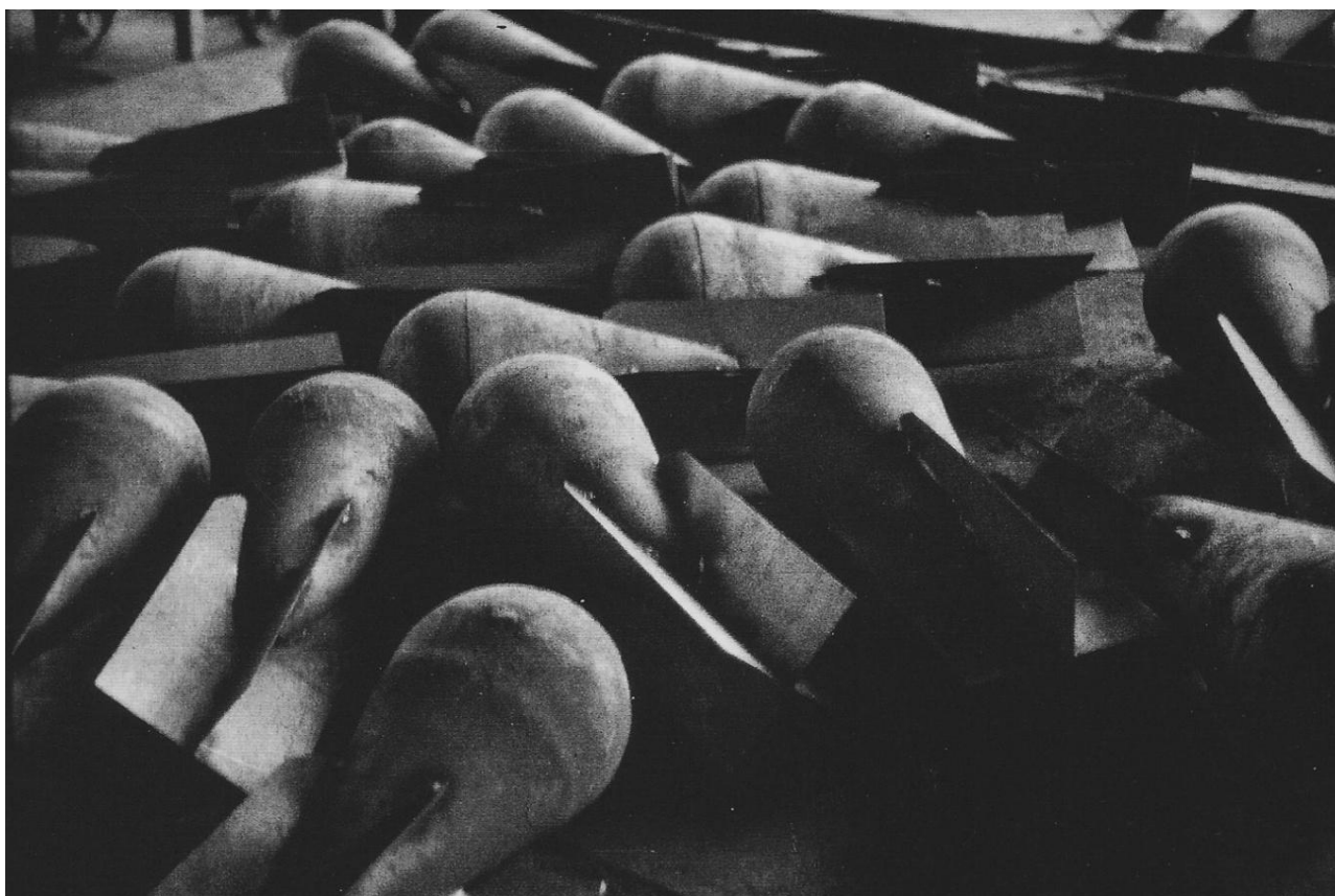
Bombas aeronáuticas en construcción en los talleres de “Moreda y Gijón” para la aviación asturiana.(Fotografía Museo del Pueblo de Asturias, Gijón. Colección Constantino Suárez)
