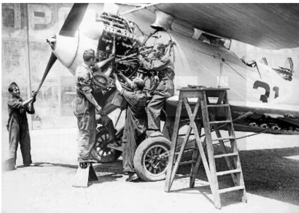
Breguet XIX del Grupo 31, de Getafe en revisión de motor. Este Grupo envió nueve aviones –una escuadrilla– en refuerzo del Grupo de León para las operaciones sobre Asturias. Se aprecia un lanza-bombas 3-A-5 bajo el plano
